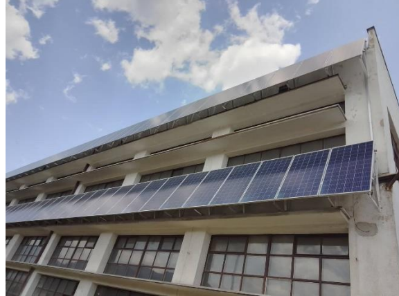
Obr – inštalácia na fasáde budovy
