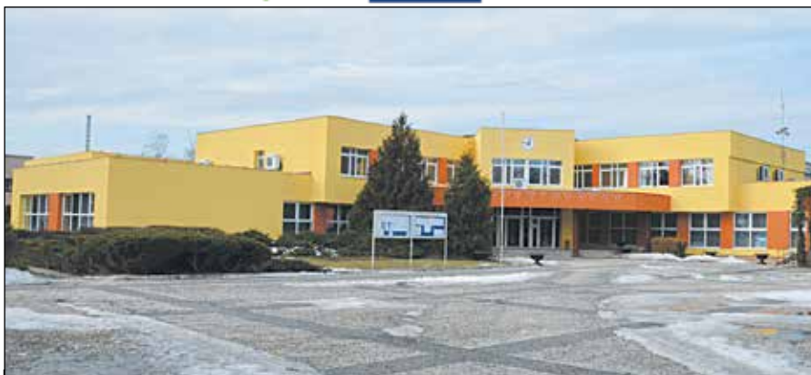
O projekte Zvyšovania energetickej účinnosti budovy mestského úradu sme v novinách informovali, ako aj o finančnom krytí väčšej časti nákladov z fondov Európskej únie. Na snímke P. K. je pohľad na nový šat budovy. Snímka: P. K. Text: –red.–
