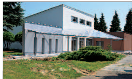
Ako vidno (snímka P. Kičinka) Dom smútku - stavebný objekt 01 (SO 01) je zrekonštruovaný a stavebne upravený, ale je potrebné zrealizovať, resp. dokončiť: SO - 02 - kanalizačnú prípojku, výmenu vykurovacích telies (gamatiek), vonkajšie osvetlenie, osadenie záhonových obrubníkov so zasypávaním okrasného štrku, terénne úpravy.
